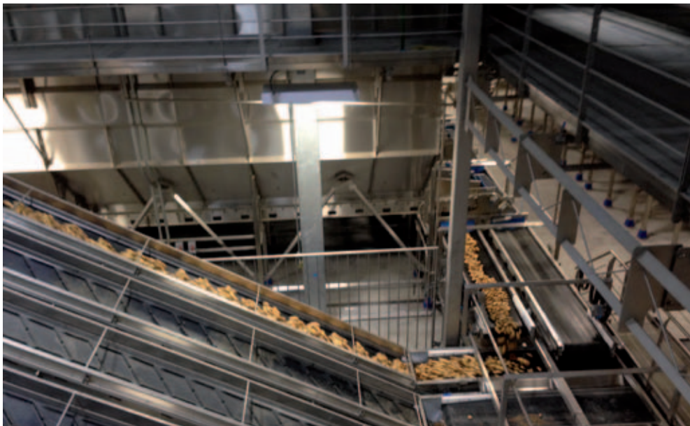
Since November 2013 | Plant in test mode Seit November 2014 | Anlage im Testbetrieb
